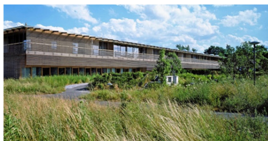
Figura 01.34 – Fotografia vista do exterior do ReHab Basel (2002)
