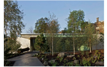
Figura 03.24 – Vista exterior da entrada do Maggie's Gartnavel
