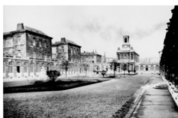
Figura 01.11 – Fotografia do pátio central do Hospital Laribosière em Paris (em 1846)
