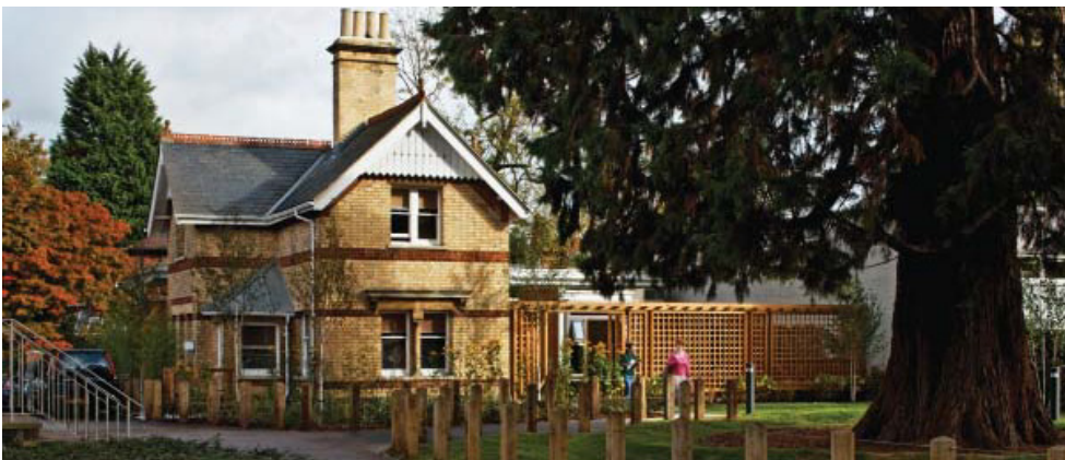
Figura 03.9 – Vista exterior da fachada sul do Maggie's Cheltenham
